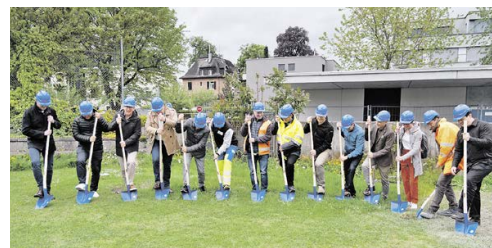
Die ersten Löcher für die Fernwärmezentrale sind ausgehoben. Voraussichtlich 2027 soll sie erstmals Wärme liefern. (Bild: bre)
